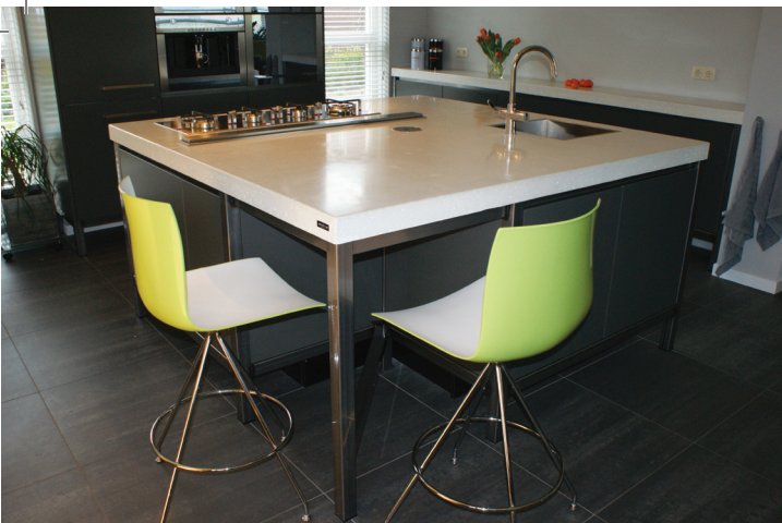
vb. wit betonnen aanrecht, waslaag finish
